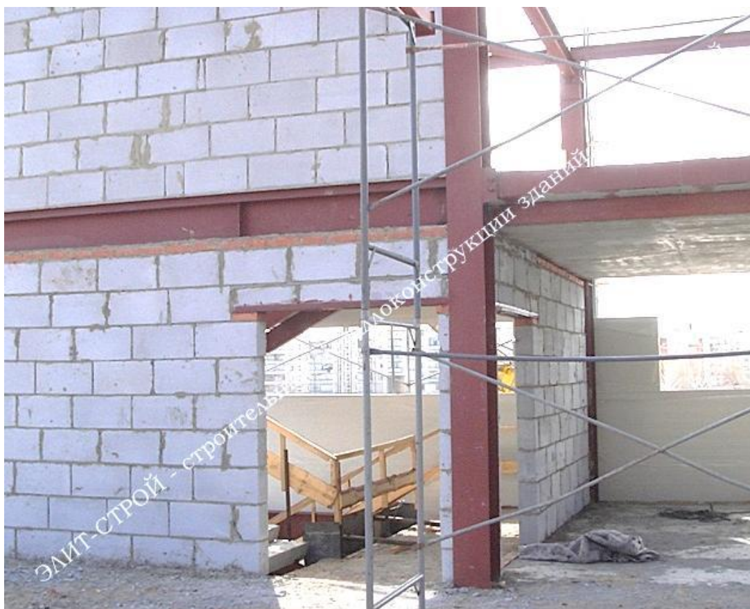
Рисунок 4.43 – Перегородки из пеноблока
