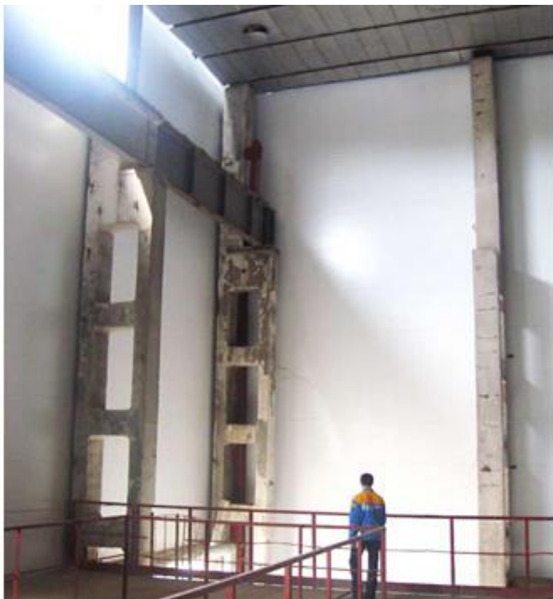
Рисунок 4.28 – Вид торцевого фахверка
